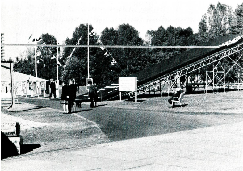
Bild 24 Teilansicht des Kanalquerschnitts in Originalgrösse. Die Besucher sind sozusagen «auf Grund gelaufen». Das Querband im oberen Drittel der Aufnahme stellt die Wasserlinie dar. Rechts anschliessend die Uferböschung.
