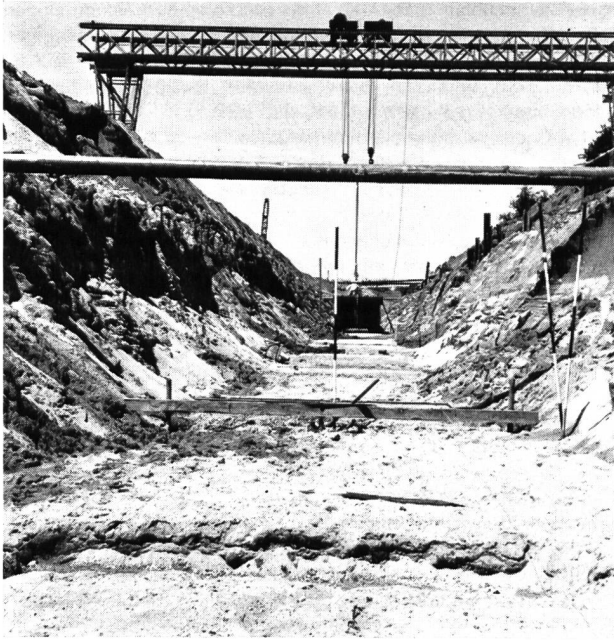
Baugrube des Zulaufkanals zur Abwasserkläranlage Altenrhein in siltigem Boden (Rheinletten) bis 6 m UK Grundwasserspiegel. Grundwasserabsenkung Wellpoint-Verfahren. (Photo: Bertschinger)
