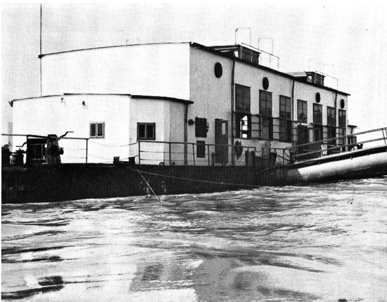
Bild 9 Schwimmende Pumpanlage in Bulgarien.
