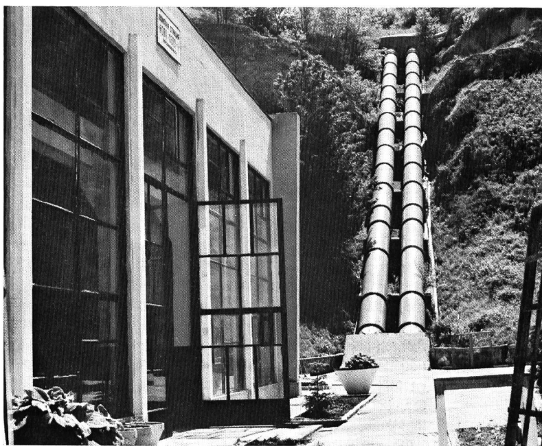
Bild 8 Druckleitung der Pumpanlage Novo Selo des Bewässerungssystems «Novo Selo-Vidin».
