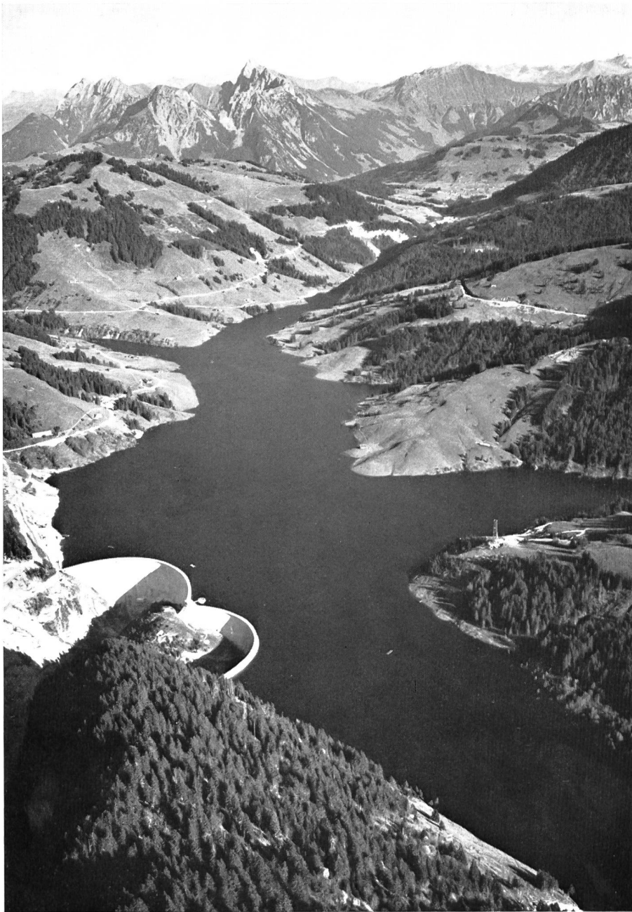
Fig. no 3 Vue aérienne du double barrage voûte et d'une partie du lac d'accumulation Hongrin.
