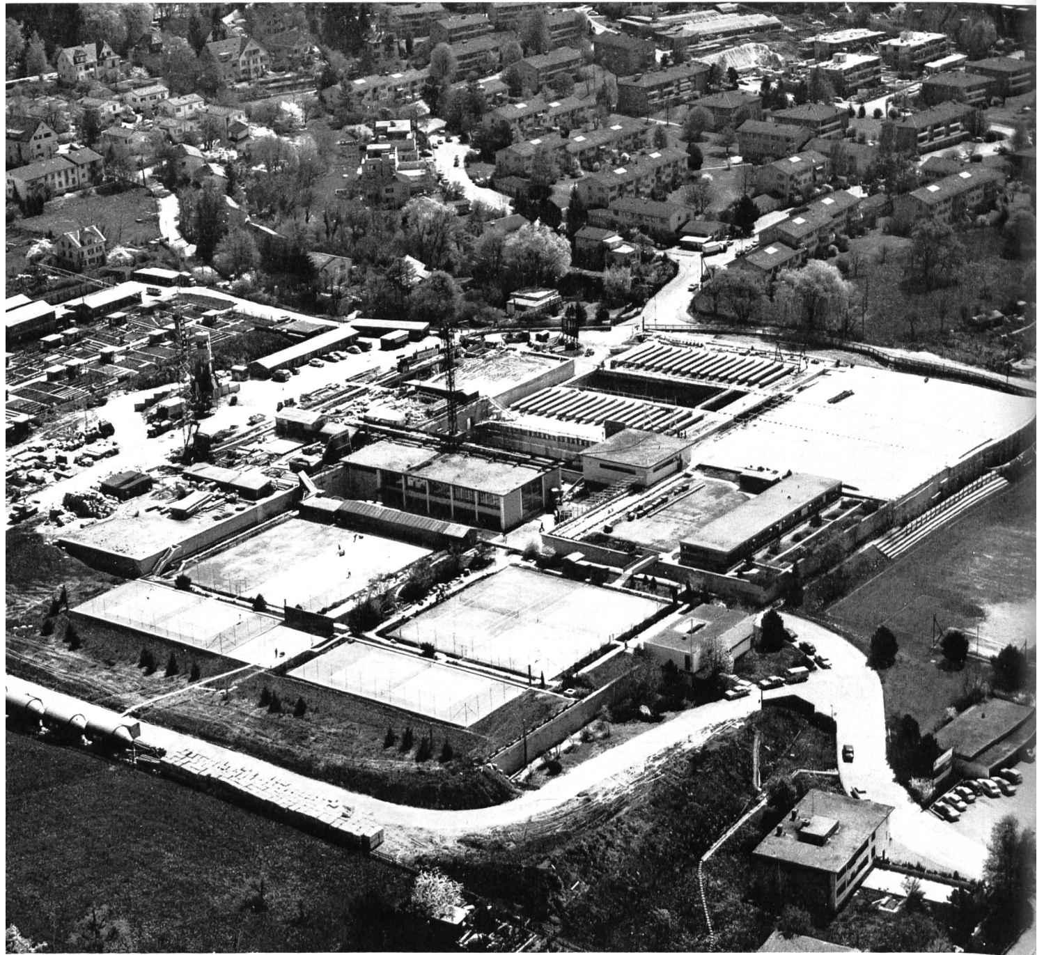
Erweiterung Seewasserwerk Lengg in Zürich
