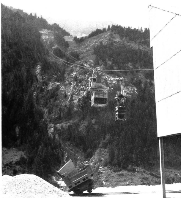
Bild 3 18- und 5-Tonnen-Seilbahnen zum Wasserschloss Mapragg.
