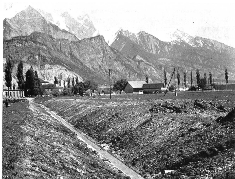
Bild 4 Wolfrietgraben mit Sohlenschutz und Drainageeinmündungen.
