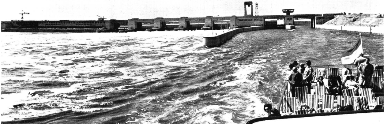
Bild 4 Im Unterwasser des Kraftwerks Ottensheim-Wilhering; man beachte die technisch-architektonisch ausgezeichnete Lösung mit der durchgehenden Horizontalen.
