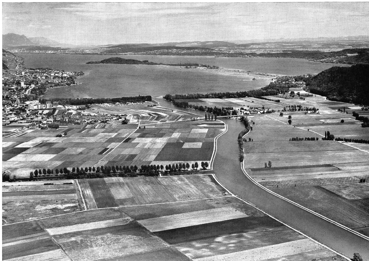
Bild 6 Der den Neuenburger- und Bielersee verbindende Zihlkanal bei der Mündung in den Bielersee, nach Beendigung der Bauarbeiten; im Hintergrund die Petersinsel.
