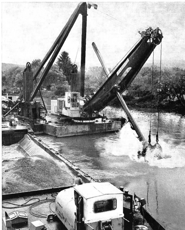
Bild 5 Der amerikanische Manitowoc-Schwimmbagger bei der Arbeit im Nidau-Büren-Kanal. Zurzeit ist er im 24stündigen Tageseinsatz in Finnland tätig!
