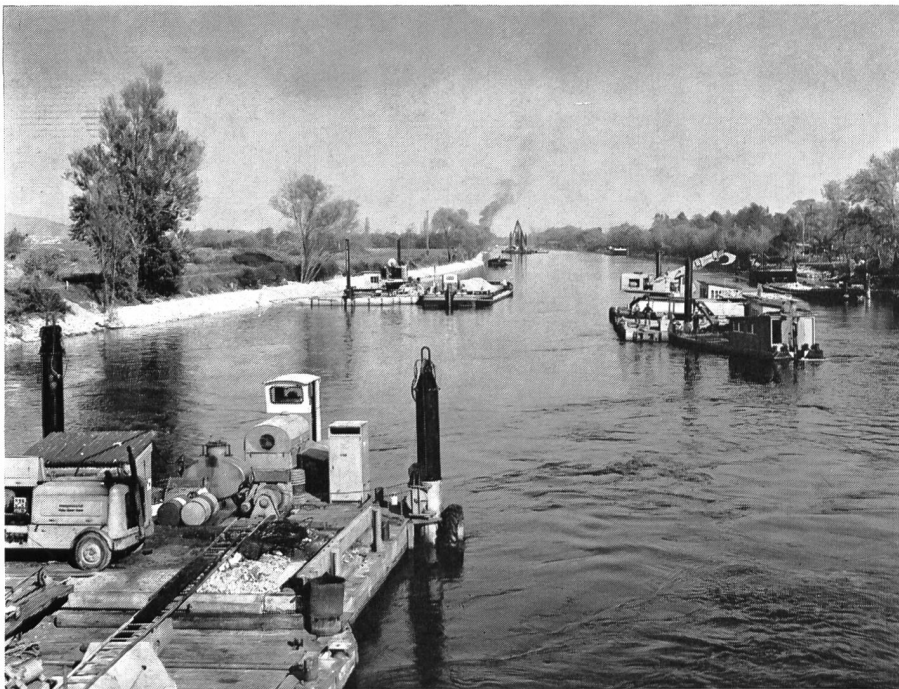
Bild 3 Arbeitsfront im Nidau-Büren-Kanal.
