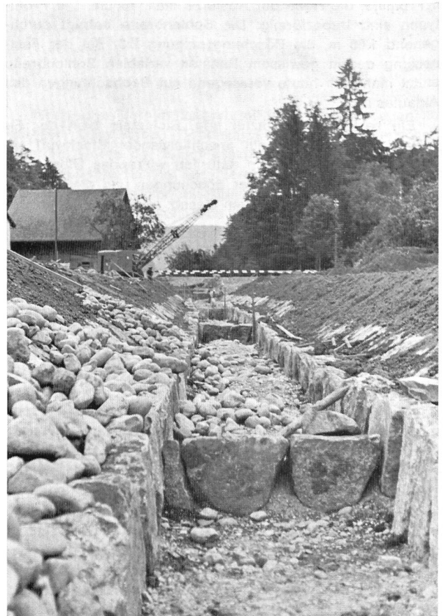
Bild 5 Fisibach. Die Natursteine halten durch ihr Gewicht dem Angriff des Wassers stand; sie müssen deshalb nicht zusammenwirken. Die Fugen können gross sein und offen bleiben; sie dienen als Unterschlupf für Fische und Ansatzfläche für den Bewuchs.
