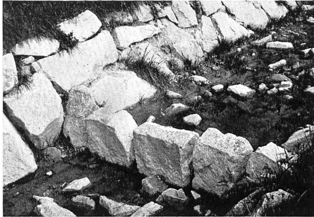
Bild 1 Egliswilerbach. Böschungssicherung mittels unverfugtem Blockwurf; Natursteinschwelle in der durchlaufenden Bachsohle.
