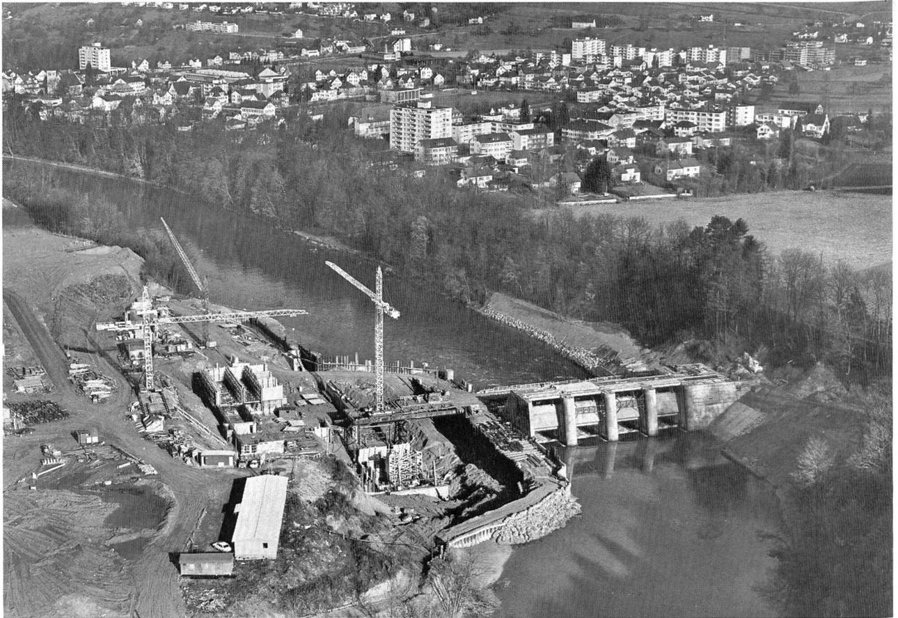
Bild 5 Flugaufnahme der Baustelle für Maschinenhaus und Wehr des Reusskraftwerkes Bremsgarten-Zufikon: Rechts die Wehrröffnungen 2 bis 5, in der Bildmitte die Maschinenhausbaugrube, links das Unterwerk (Photo Comet, Zürich, vom 8. 1. 74).
