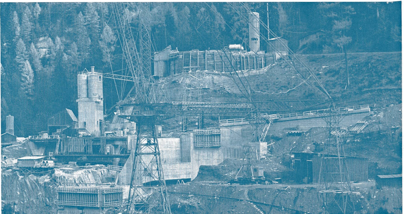
Kraftwerke Sarganserland. Staumauer Mapragg
