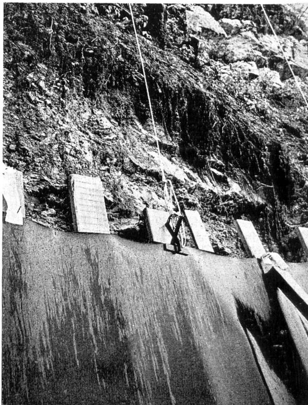
Bild 6 Hochziehen der Folien im Bereich der Felswand.
