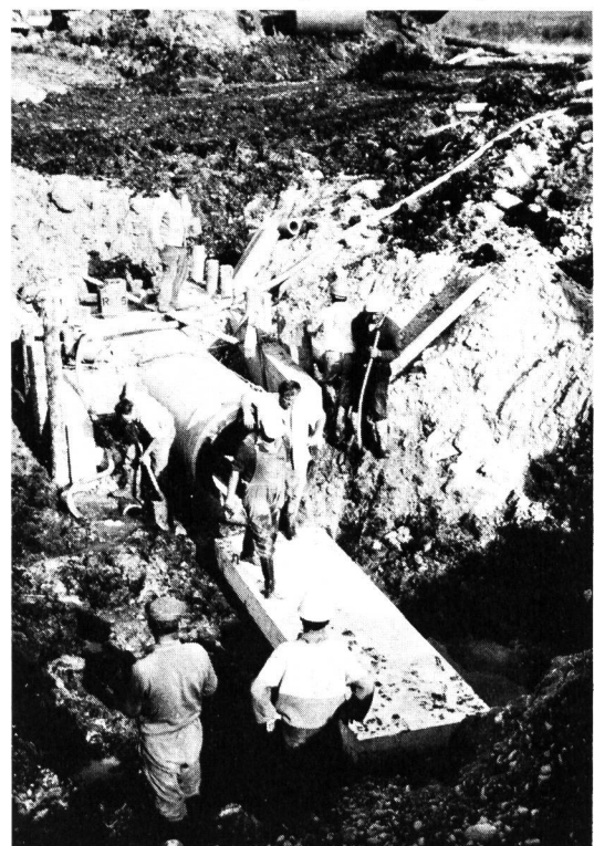
Bild 12 Pfahl-Platten-Gründung des Bibertal-Hauptsammlers.
