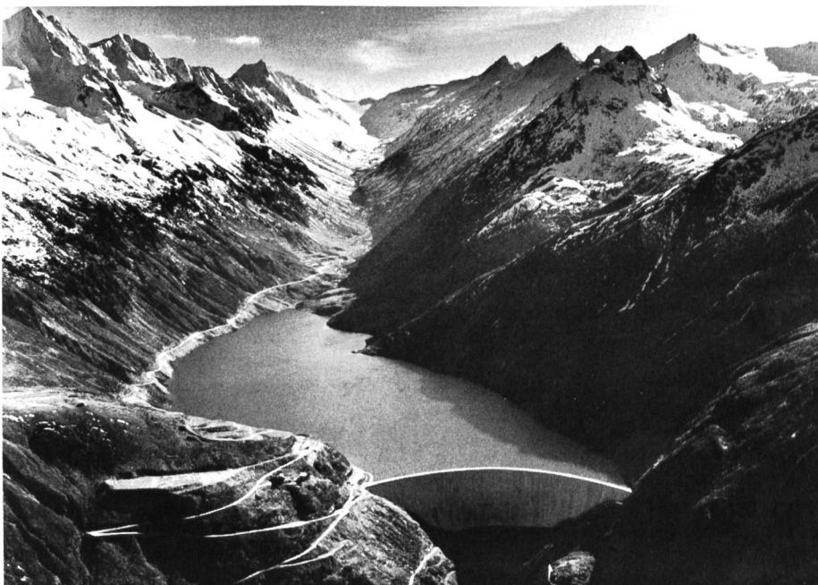
Bild 1 Staumauer und Stausee Naips der Vorderrhein-Kraftwerke.
