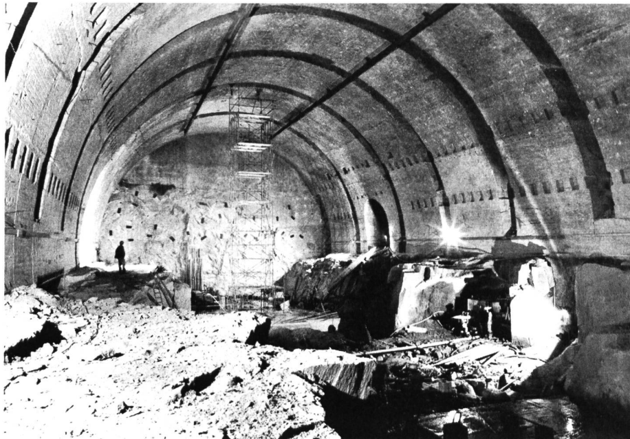
Bild 8 Zentralen-Kaverne Handeck III, Bauzustand Januar 1975.
