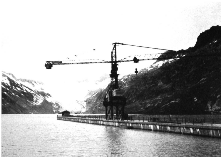
Bild 3 Bauinstallationen auf der Staumauer Oberaar.
