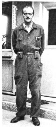
Bild 2, links. Der Schichtmann trägt an seinem Leibgurt links den Geber, rechts den Zeitmelder.
