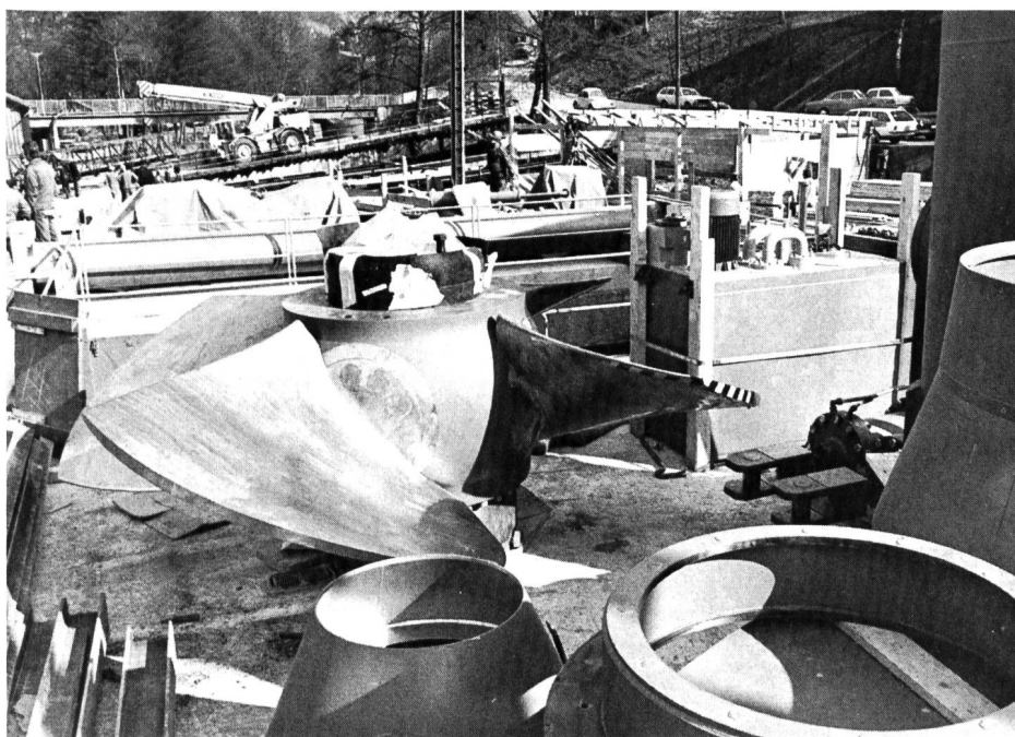
Bild 2. Das Kaplan-Turbinenrad, Durchmesser 3650 mm, steht auf der Decke des neuen unterirdischen Maschinenhauses bereit, um rund 10 m tiefer eingebaut zu werden.
