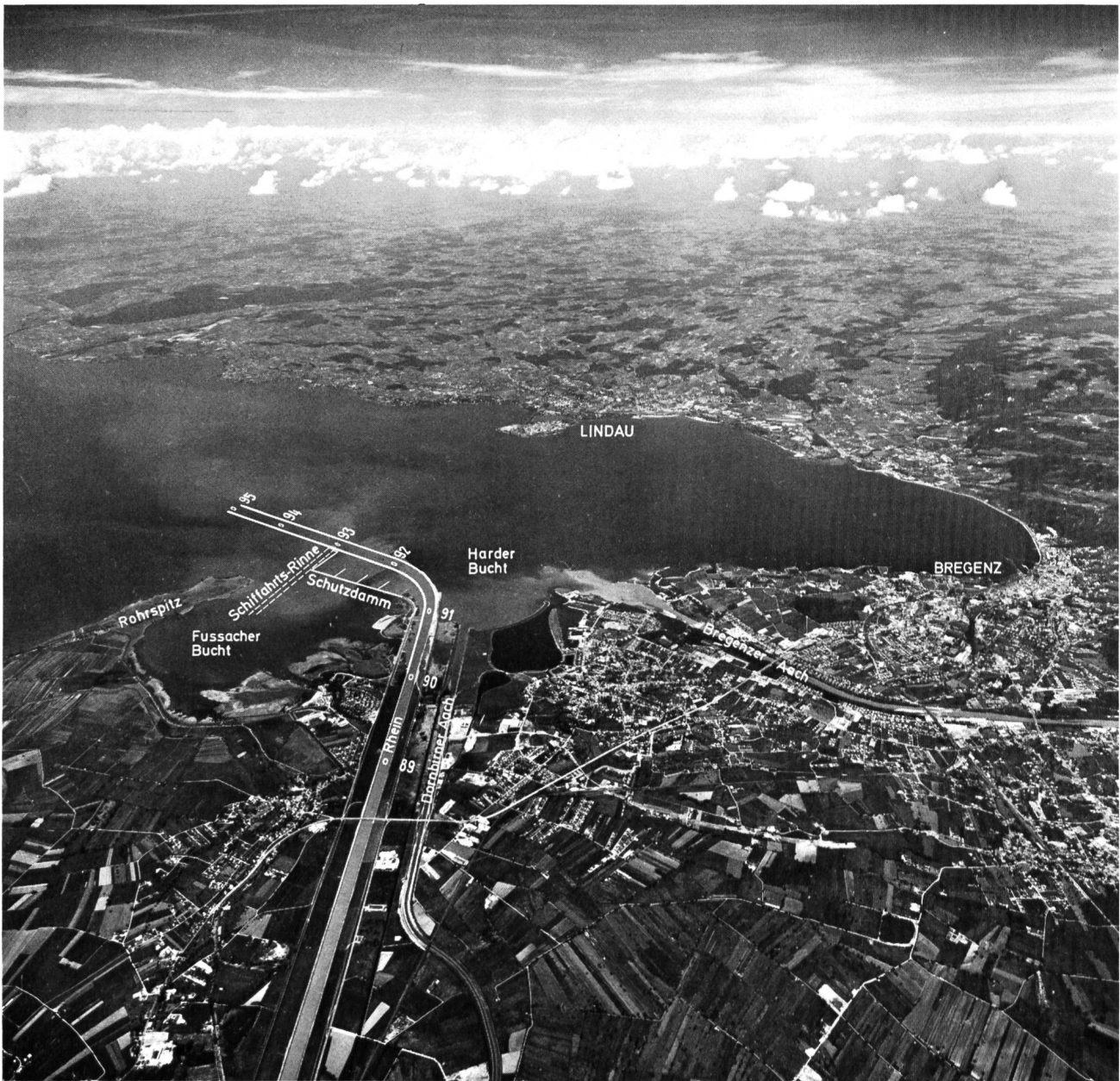
Bild 2 zum Aufsatz H. Bertschinger: Wasserbauliche Probleme an der Mündung des Alpenrheins in den Bodensee.
