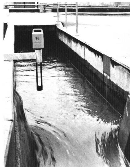
der Wassermenge, bezogen auf den jeweiligen Momentanwert im mittleren und unteren Messbereich, ergibt sich die Forderung nach einer Wasserstandsmessung auf  $\pm 0,25$  %, bezogen auf den Endwert.
