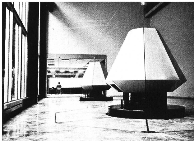
Bild 4. Der neue Maschinensaal des 1969/70 erneuerten Kraftwerks Campocologno. Die mittlere jährliche Erzeugungsmöglichkeit konnte von 112 Mio kWh auf 174 Mio kWh gesteigert werden.
