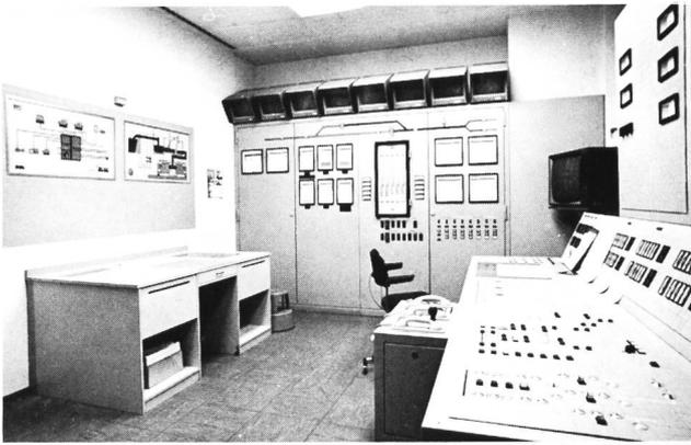
Bild 18. Zentralwarte im Rheinkraftwerk Albruck-Dogern für die Fernsteuerung und Fernüberwachung des Maschinenhauses, des Wehrs, des Aubeckens und des Pumpwerks Full.
