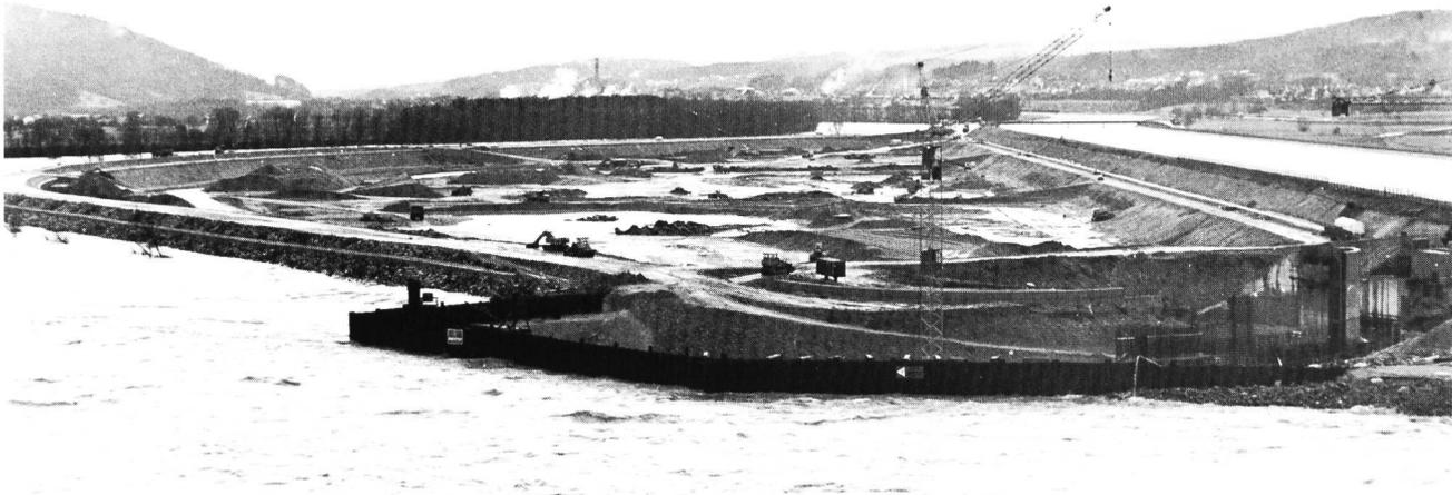
Bild 13. Hochwasser im Rhein von etwa 2200 m<sup>3</sup>/s am 10. Februar 1977. Im Vordergrund fließt der Rhein unterhalb des Wehrs an der Baugrube für den Auslaufkanal vorbei (von rechts nach links). Vom rechten Bildrand gegen die Bildmitte verläuft die Fließrichtung des Oberwasserkanals des Rheinkraftwerks Albruck-Dogern. Rechts die Baugrube des Ein- und Auslaufbauwerks, in Bildmitte die Aushubarbeiten für das Aubecken.
