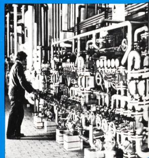
SERVO-Anschwemmfilter zur Vorbehandlung und Feinstreinigung für Frischwasser und Kondensat.
