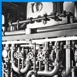
Filteranlagen SERVO. Automatisch. Auch zur Enteisung, Entmanganung, Entchlorung, Geschmacksverbesserung.
