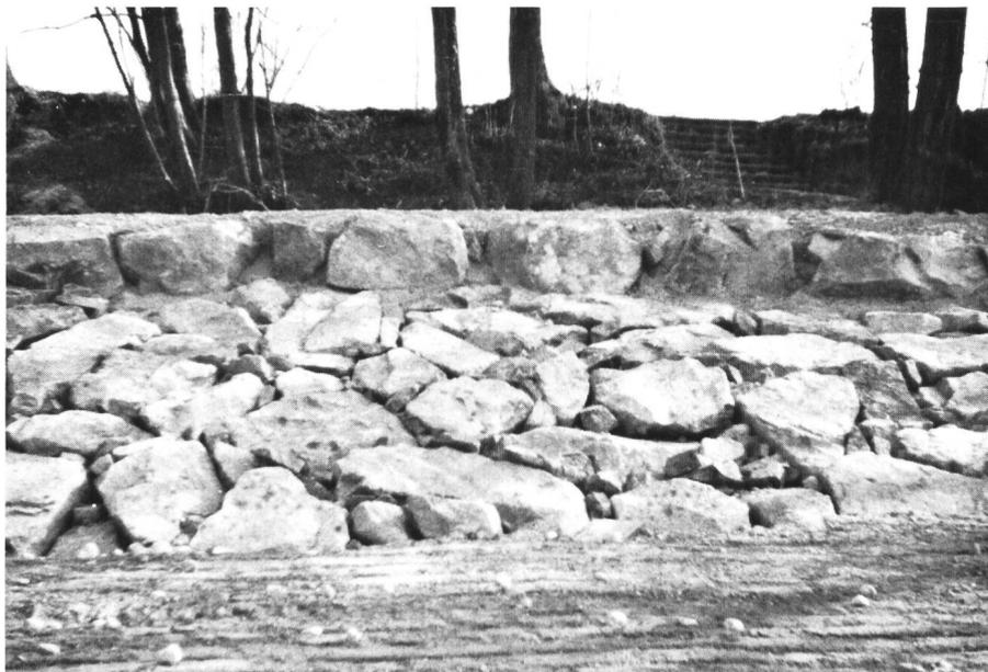
Bild 8. Teststrecke bei Rheinklingen 1976. Bild der fertigen Versuchsböschungen.
