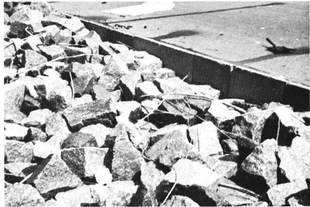
Bild 5. Sohlsicherung.
