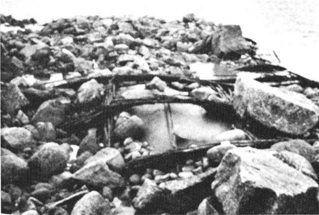
Bild 4. Beschädigtes Deckwerk.
