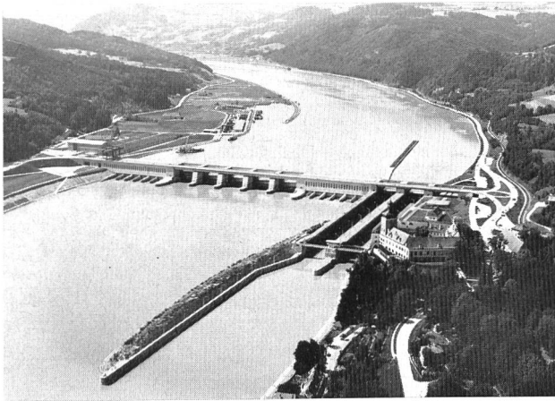
Bild 2. Donau-Staumstufe Ybbs-Persenbeug, elektrische Leistung 200 MW, im Vordergrund Schloss Persenbeug. (Foto: Österr. Donau-KW)
