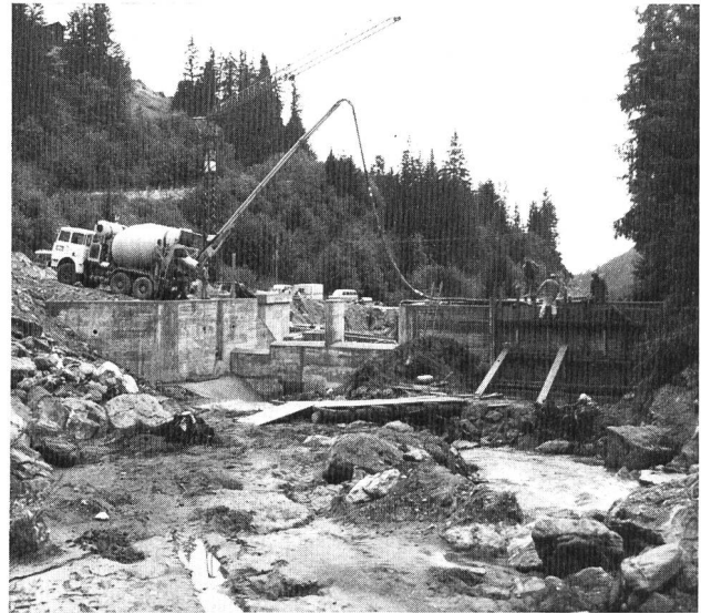
Figure 3. La prise d'eau. Vue amont. Travaux de bétonnage.
