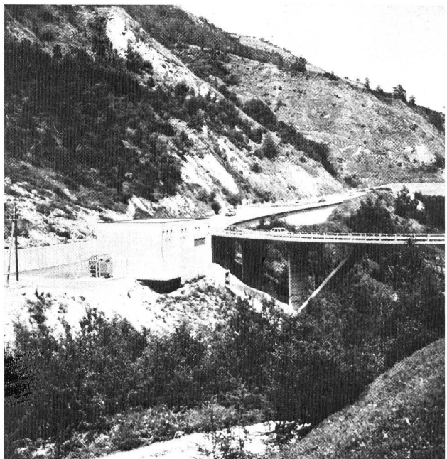
Figure 1. La centrale Sauterot sur la rive gauche de la Dixence. Elle est équipée d'un groupe de 4300 kW composé d'un alternateur et d'une turbine Pelton à axe horizontal.
