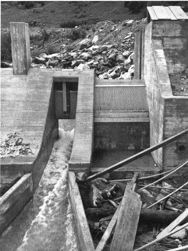
Figure 4. La prise d'eau. Vue aval. A gauche la vanne de purge, à droite la grille de la prise d'eau.
