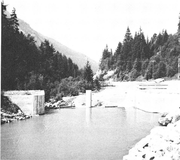
Figure 2. La prise d'eau. Vue amont.
