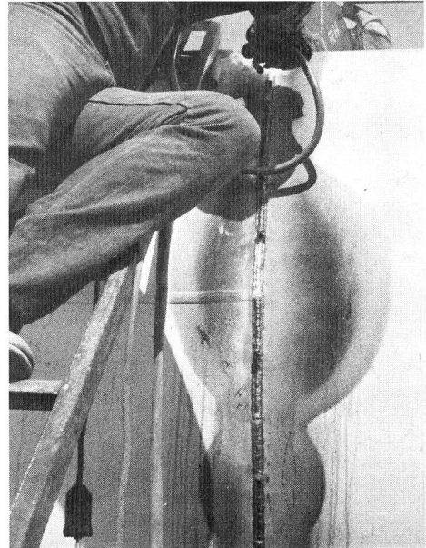
Bild 2, links. Schäden in der Nähe der Schweissverbindungen haben als Ursache oft die mangelnde Abdeckung der angrenzenden fertigen Beschichtung . . .
