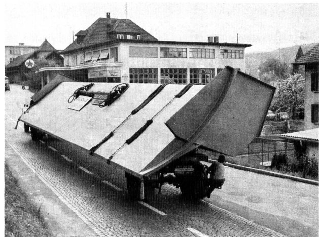
Bild 23. Stauwehr Aarau. Transport einer der vier Segmentschützen auf Zug, 1962/63.
