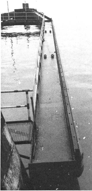
Bild 2. Molenkopf in Betonkonstruktion mit aufgesetzten PE-Gleitleisten als Ramm- und Verschleisschutz. (Werkfotos der Firma Schlegel GmbH, Hamburg)
