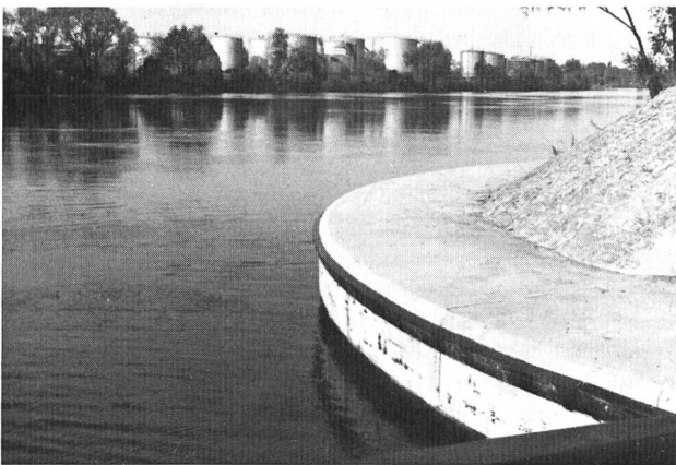
Bild 2. Molenkopf in Betonkonstruktion mit aufgesetzten PE-Gleitleisten als Ramm- und Verschleisschutz. (Werkfotos der Firma Schlegel GmbH, Hamburg)
