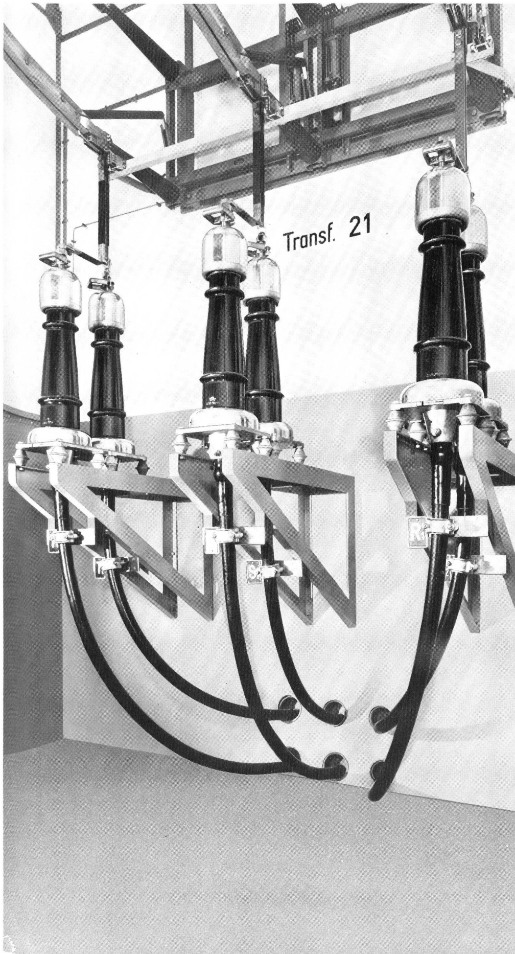
60 kV Einleiter-Oelkabel 1x800 mm 2 mit Innenraum-Kabelendverschlüssen als Verbindungsleitung zwischen Schaltanlage und Transformator in einem Unterwerk 220/60 kV
