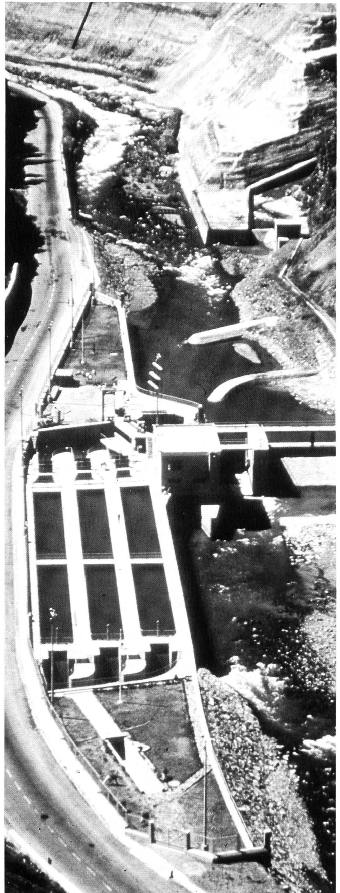
Bild 3, links oben. Wasserseitige Ansicht der 82 m hohen Pfeilerstaumauer Al Massira während des Baus. Bild 4, links unten. Die 2753 m lange Druckleitung des Wasserkraftwerks Santa Isabel in Bolivien wurde ohne Expansions-Fixpunkte gebaut. Bild 5, rechts. Ausgleichbecken des Wasserkraftwerks Matucana in Peru. Gefälle 864 m, Leistung 360 MW.
