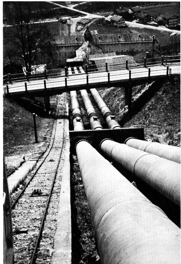
Bild 1. Blick talabwärts auf die alten Druckleitungen mit den Fixpunkten 4 im Vordergrund und 5 unterhalb der Strassenbrücke. Im Talgrund ist die Zentrale Küblis mit dem Unterwasserkanal zur Landquart sichtbar.
