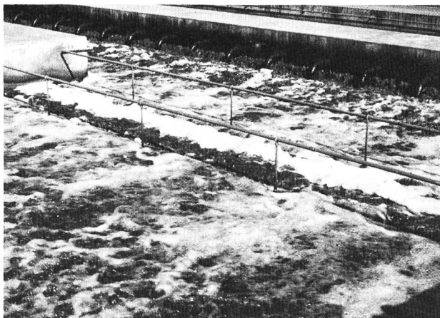
Bild 4. Belüftungsbecken in der Kläranlage Werdhölzli. Die hier entstehenden Aerosoltröpfchen sind Träger von Mikroorganismen.
