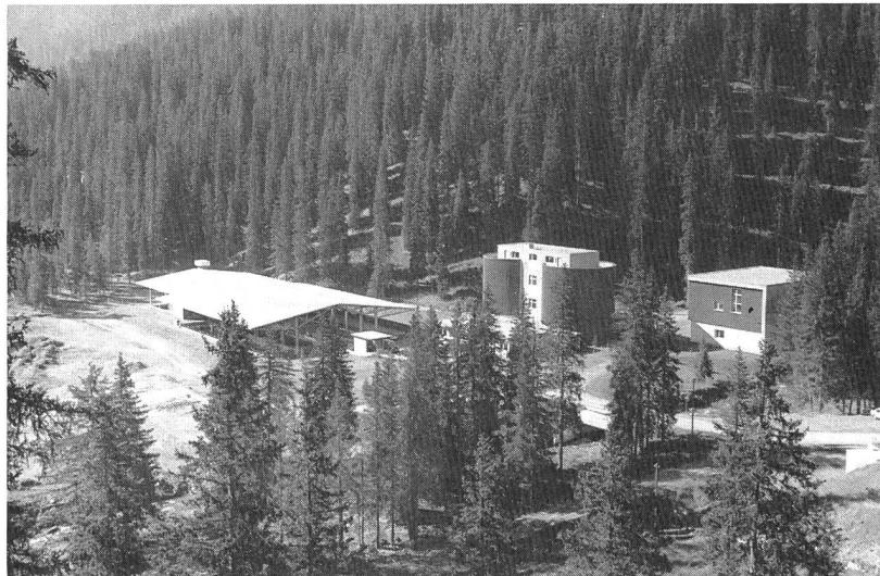
Bild 1. Die Abwasserreinigungsanlage Arosa liegt auf 1610 m ü. M. und ist ausgelegt für 19 000 hydraulische und 32 000 biologische Einwohnergleichwerte. Faulräume und Klärschlammwässerungsgebäude rechts im Bild (Kammerfilterpresse).
