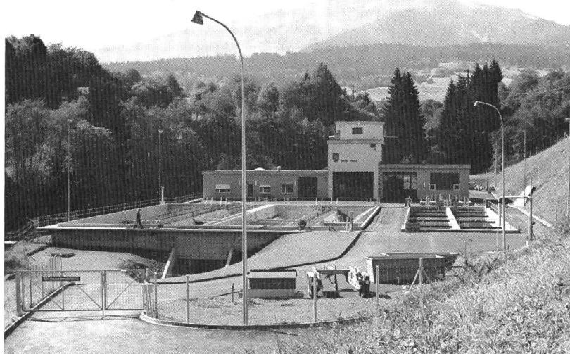
Bild 2. Die Abwasserreinigungsanlage Flims liegt auf 1000 m ü. M., sie ist ausgelegt für 19 000 hydraulische und 24 000 biologische Einwohnergleichwerte, Klärschlammwässerungsgebäude im mittleren Teil; vorne die Turmfilterpresse, hinten der Faulraum.
