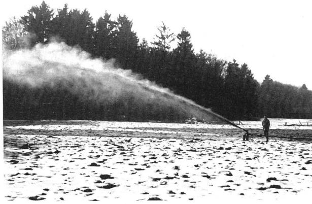
Bild 9. Faulschlammverteilung aus einem Stapelbassin.
