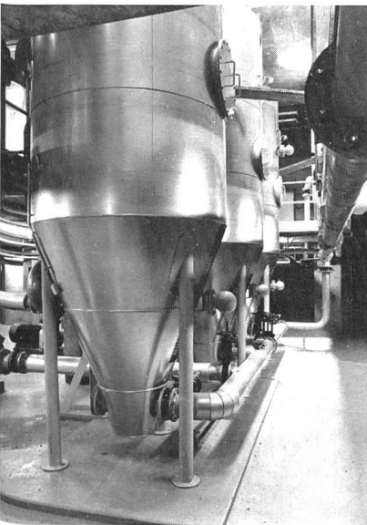
Bild 3, links. Teilansicht der Chargen-Pasteurisierungsanlage in der Kläranlage Altenrhein.
