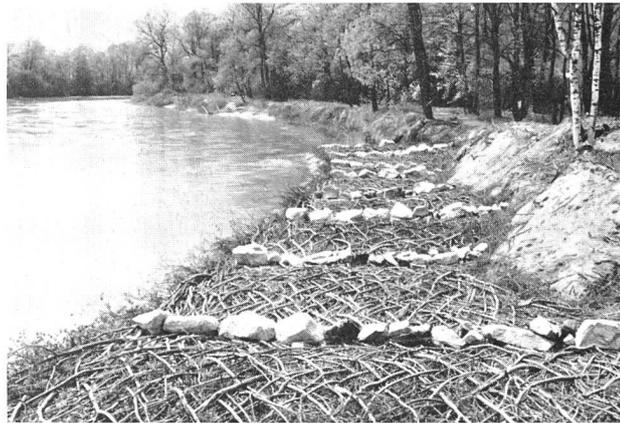
Bei der Gitterbauweise an der steirischen Enns werden nach ingenieurbio-logischen Erkenntnissen Pflanzen als «Lebendverbauungen» der Flussufer eingesetzt. Die Stecklinge beginnen bereits auszuschlagen.
