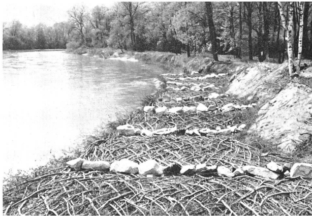
Bei der Gitterbauweise an der steirischen Enns werden nach ingenieurbio-logischen Erkenntnissen Pflanzen als «Lebendverbauungen» der Flussufer eingesetzt. Die Stecklinge beginnen bereits auszuschlagen.
