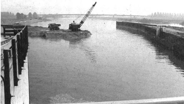
Bild 17. Entfernen eines Abschlussdammes bei der Schleuse Straubing.
