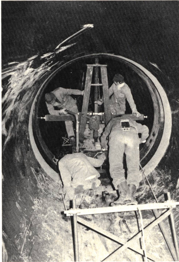
Figure 6. Mise en place d'une nouvelle virole du puits blindé.
