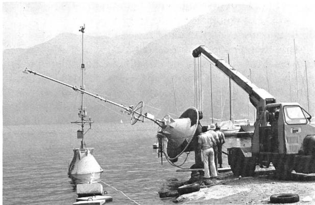
Bild 9. Einwasserung meteorologischer Bojen. Bojenlänge ü. a.: 12 m, Gewicht: 1,2 t.
