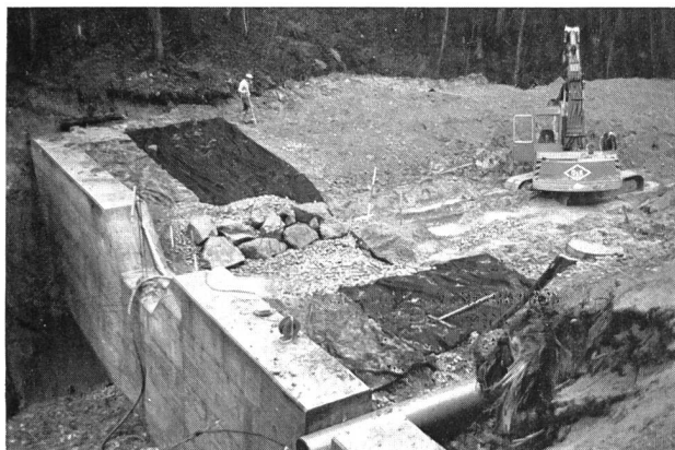
Bild 2. Um das Auffüllmaterial gegen Ausschwemmungen zu sichern, wurde ein Haté-Gewebe eingesetzt.
