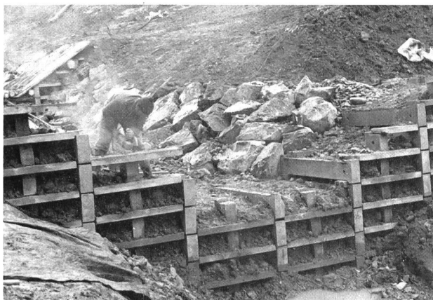
Bild 3. Zwischensperren bis 70 cm Absturzhöhe wurden mit Beton-Fertigelementen gebaut (Krainerwand).
