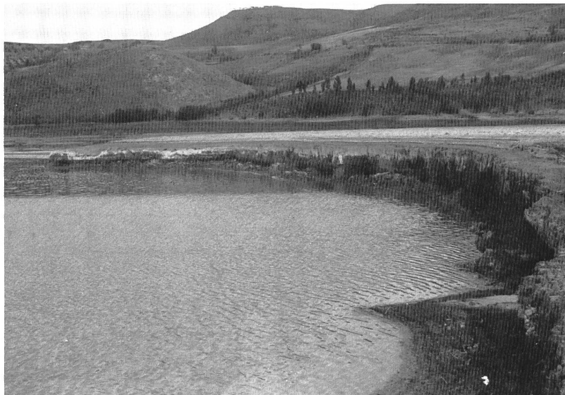
Figura 4. Lago Abate Alonia (Puglia – Italia). Il lago è vuoto dopo i lavori di sfangamento. Il fronte di scavo, alto 8 m circa, divide la zona sfangata da quella ancora da sfangare.
