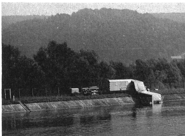
Bild 2. Die fahrbare Einrichtung zum Sanieren der Fugen und Querrisse im RADAG-Werkkanal.
