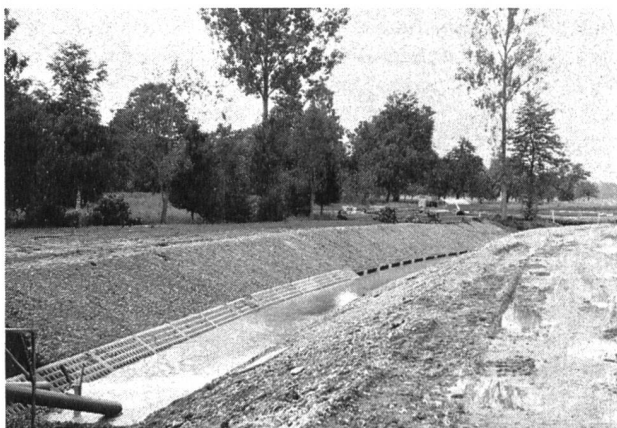
Bild 5. Der fertig erstellte, aber noch nicht wiederbegrünte Teil des Kanals ohne Abdichtung unterhalb des Naturschutzgebietes. (Bilder Sarna Kunststoff AG, 6060 Sarnen)
