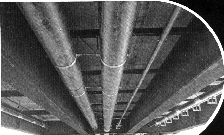
Hart-Polyäthylen-Rohre ND 3,2/ND 4, Ø 200, 450 und 630 mm
