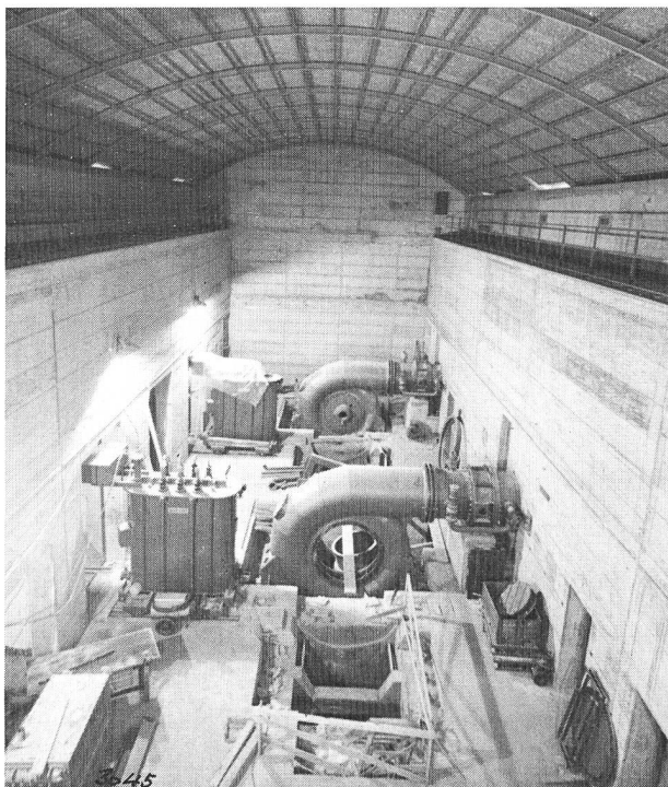
Bild 1. Das neue Kubelwerk der St. Gallisch-Appenzellischen Kraftwerke AG.
