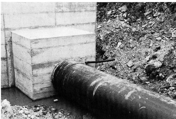
Bild 5. Der Fixpunkt am Turbinenhaus.
