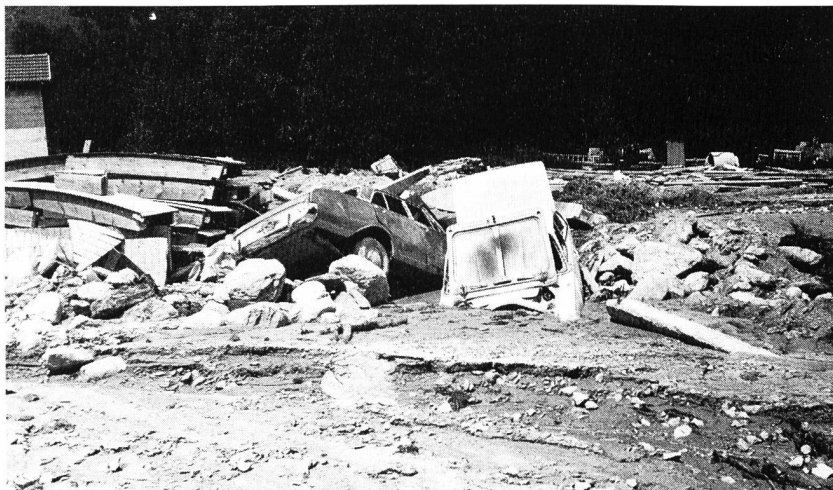
Bild 2. Die Murgangabflüsse der Vallatscha im Müstertal/Kt. Graubünden in der Periode 30. April bis 22. Juni 1977 verursachten nicht nur im Bereich des Wildbaches grosse Schäden, sondern veränderten auch den Vorfluter II Rom erheblich durch massive Geschiebeablagerungen, Flusslaufverlegungen und damit verbundene Uferabbrüche. Folgeschäden waren bis ins italienische Grenzgebiet spürbar.
