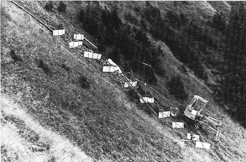
Bild 1, links. Für das Ausheben des Grabens in extrem steilem Gelände wurde ein Schrittbagger eingesetzt.
