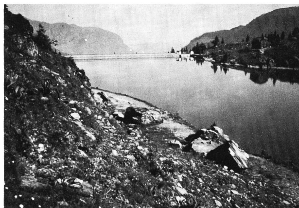
Bild 3. Bereits schmale Bermen vermögen rollende Blöcke abzufangen (Südufer Bannalpsee).
